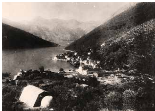
Pogled na bazu Kotor sa hangarom austrougarskog 1. balonskog odeljenja 5 puka tvrđavske artiljerije (1. Ballonabteilung /5. Festungsartillerieregiment in Cattaro , Festungsballonabteilung 1/5.Ř. ). (foto br. 15658313).
