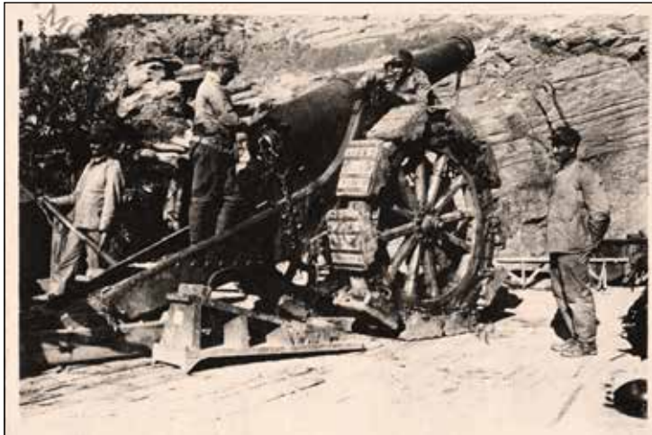
Haubica 21 cm M889 na borbenom položaju. Oruđe ima gusenice Bonagente i u pozadini, pripremljene klinove za ublažavanje trzanja.
