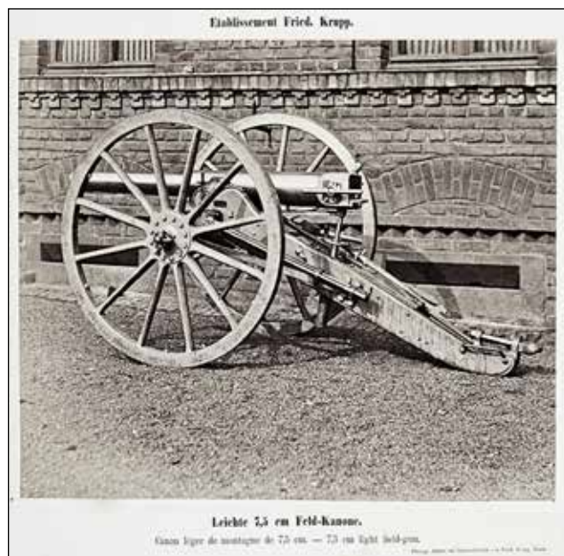
Turski laki poljski top 7,5 cm sistema Krupp na metalnom lafetu. Katalog Etablissement Fried. Krupp, Essen , 1884.
